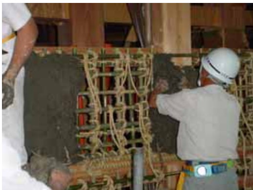
荒打ち（壁土を塗る）
