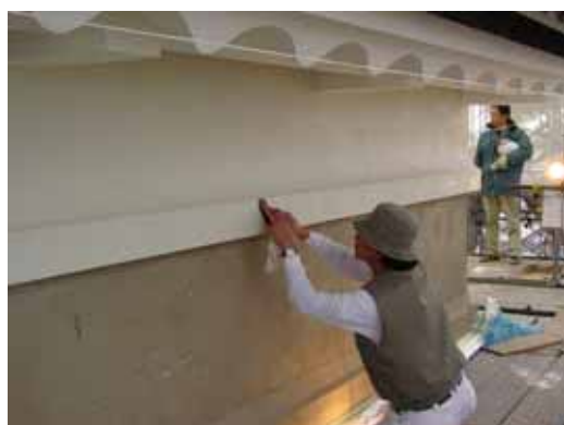
仕上げの白漆喰塗
