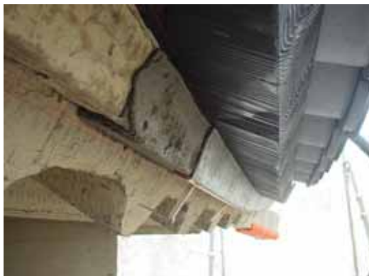
軒裏の中塗り工程
