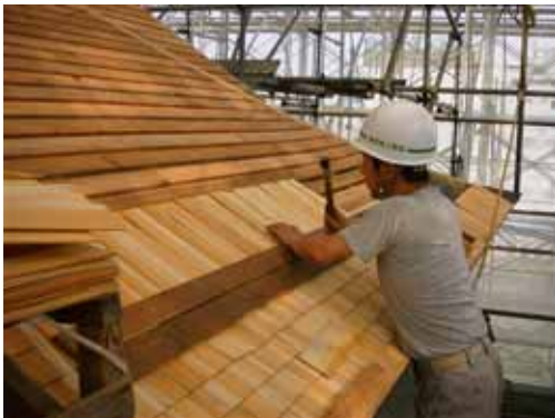
木羽葺（通称：トントン葺）の様子
